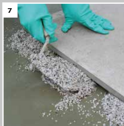
Steg 7: Fyll kanterna under plattan.
