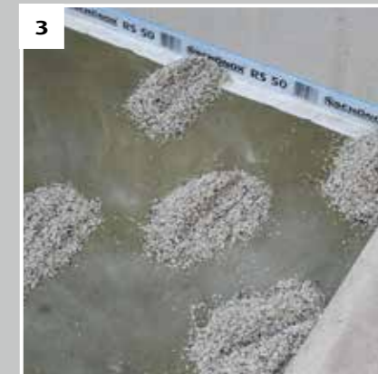
Steg 3: Lägg ut dränerbart bruk SCHÖNOX® EP DRAIN + SCHÖNOX® MONOCORN i fem högar: en i varje hörn och en i mitten
