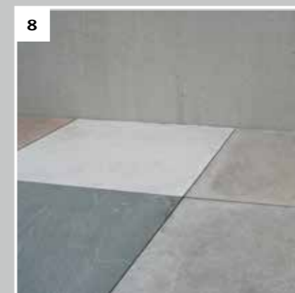
Steg 8: Fyll vid behov skarvarna med SCHÖNOX® MES.
