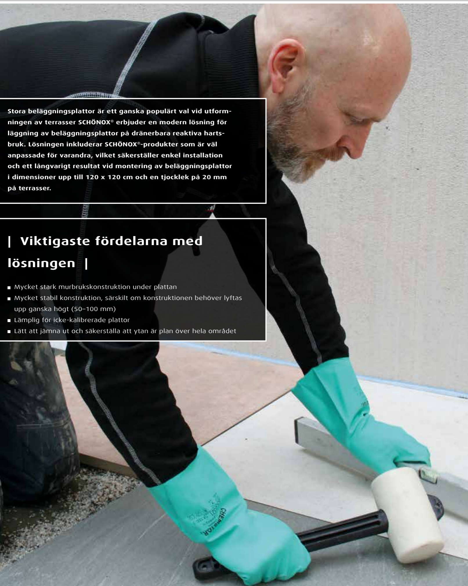
Steg 1: Underlaget bör ha ett fall på minst 2% under tätskiktmembranen SCHÖNOX® 1K DS PREMIUM
