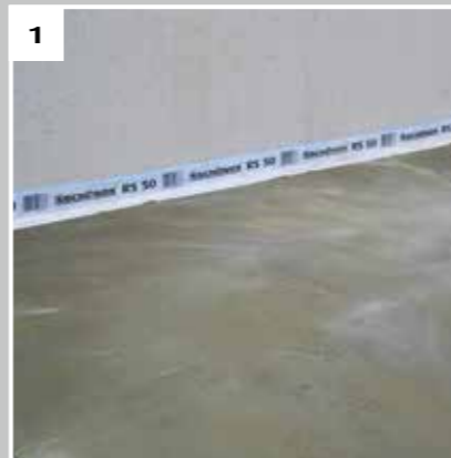
Steg 1: Underlaget bör ha ett fall på minst 2% under tätskiktmembranen SCHÖNOX® 1K DS PREMIUM
