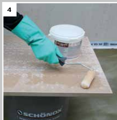
Steg 4: För bättre vidhäftning, applicera SCHÖNOX® EP Drain på plattans baksida
