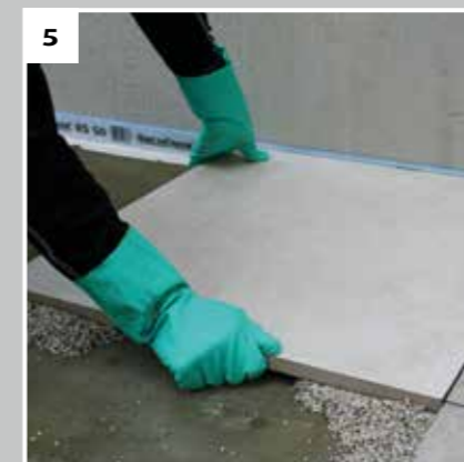
Steg 5: Lägg plattan i murbrukshögar
